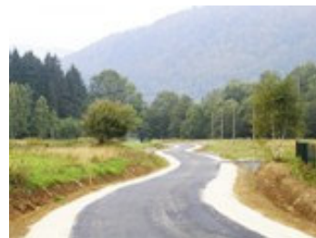
Goszów droga po modernizacji
