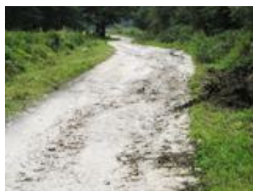
Goszów droga przed modernizacją
