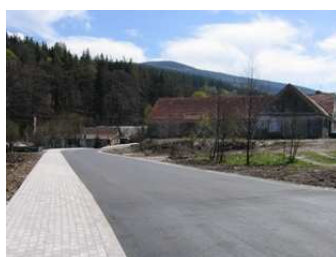
Droga po modernizacji
