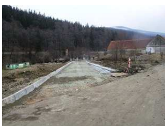
Droga przed modernizacją
