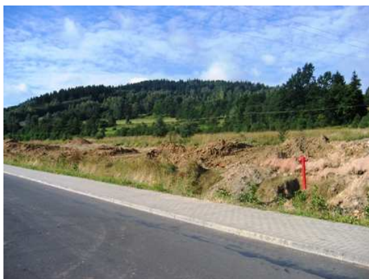
Budowa sieci wodno – kanalizacyjnej na odcinku od ul. Sportowej do Starej Morawy (zbiornik)
