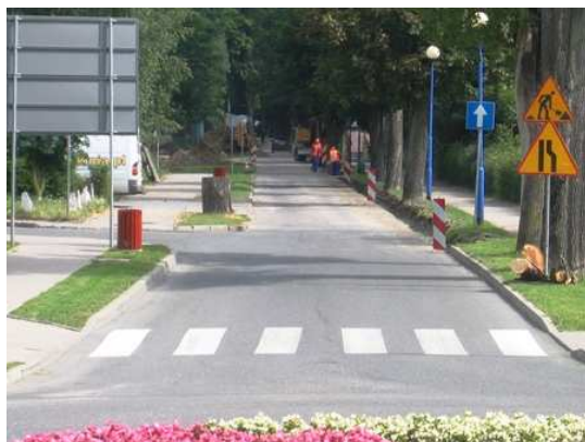
Przebudowa ul. Sudeckiej na ulicę dwukierunkową
